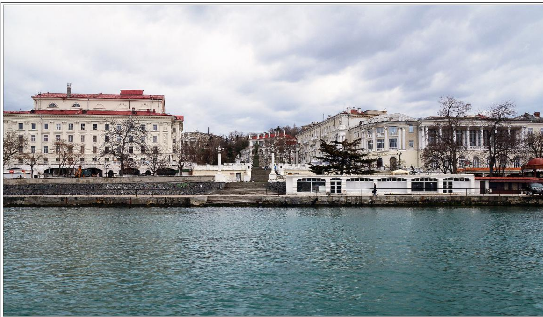
УЧАСТОК 1А Площадка между театром им. А.В.Луначарского и гостиницей «Севастополь». Вид со стороны моря. Монтаж.
