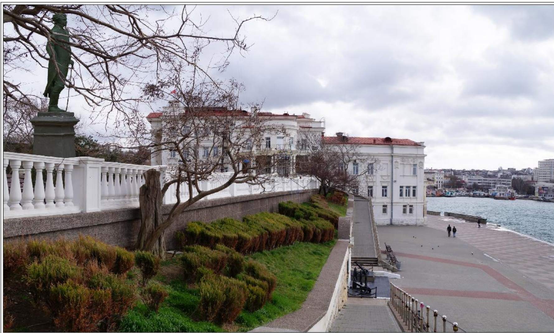
УЧАСТОК 2 Площадка между Дворцом детства и юности и Институтом биологии Южных морей (ИНБИОМ). Вид со стороны ИНБИОМ. Монтаж.
