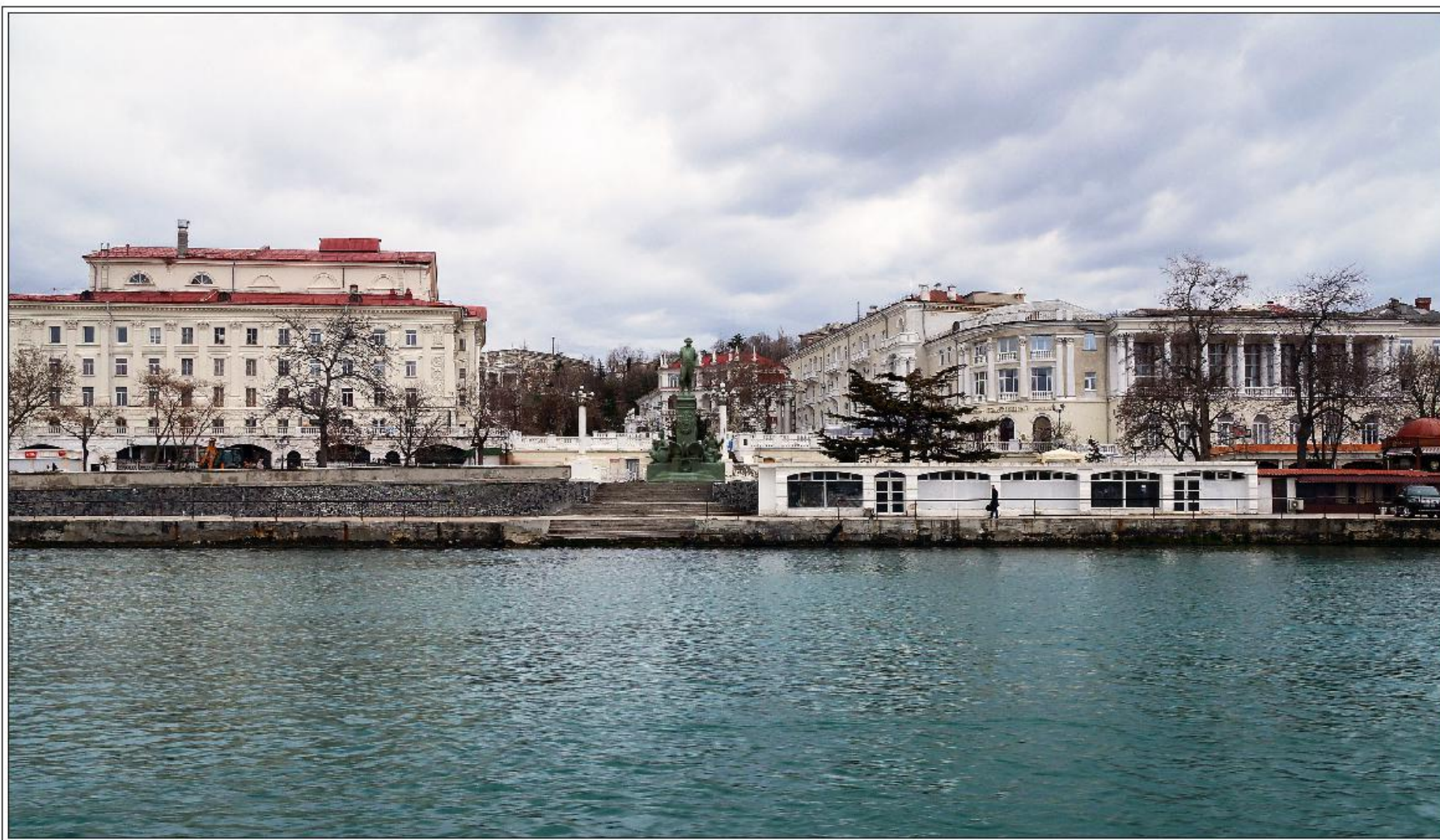
УЧАСТОК 1Б Площадка между театром им. А.В.Луначарского и гостиницей «Севастополь». Вид со стороны моря. Монтаж. (существующее положение см. стр. 12)
